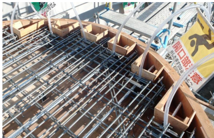
エントランスキャノピー 施工状況
