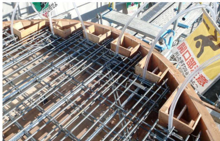
エントランスキャノピー 施工状況
